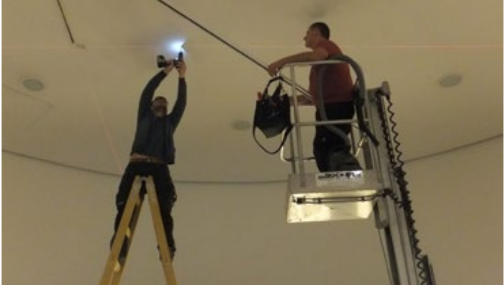
Die Technik-Mitarbeiter Matthias Sillaber und Stefan Hager bei der Schienensetzung für die LED-Spots. Foto: TLMF
