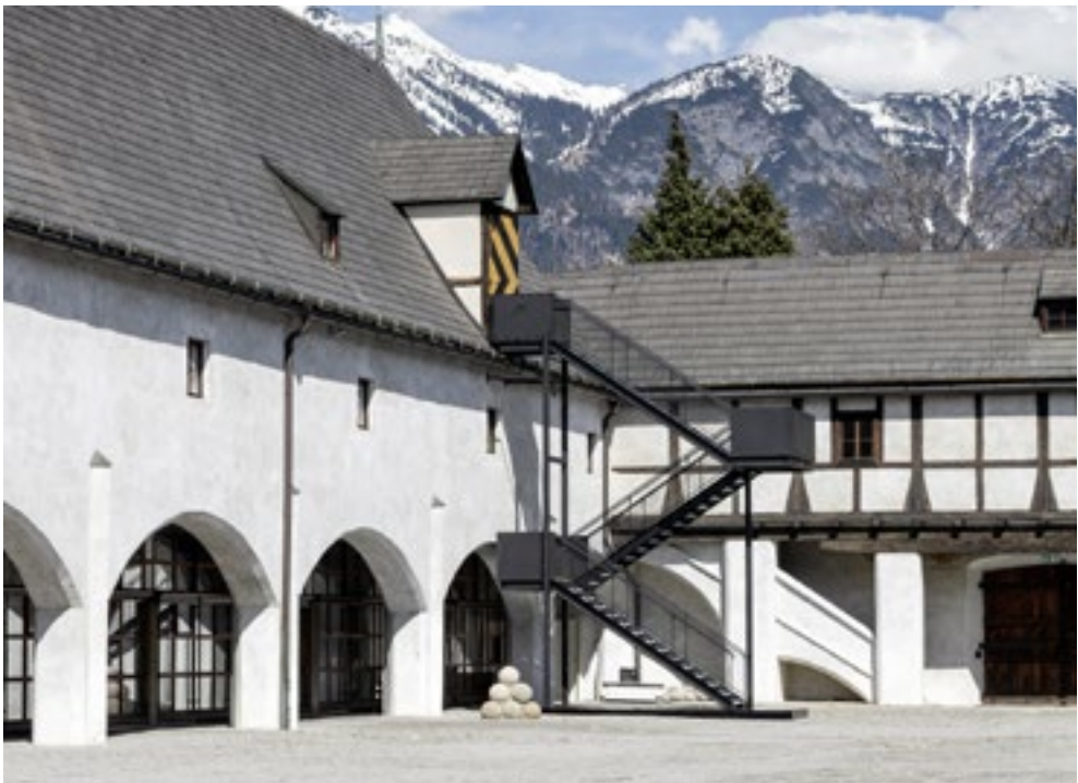
Die anlässlich der Ausstellung „Des Kaisers Zeug“ aufgestellte Stahltreppe im Innenhof des Zeughauses. Foto: Wolfgang Lackner
