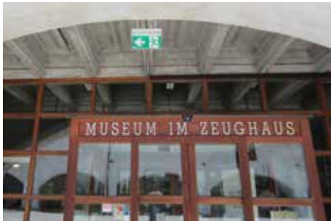
Eine Fluchtwegbeleuchtung wurde im Zeughaus installiert.
