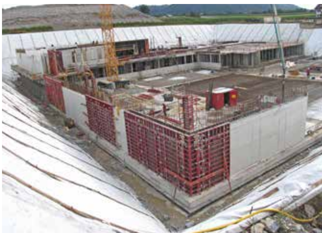
Abb. 2: Sammlungs- und Forschungszentrum. Blick von Südwesten auf die im Bau befindlichen Untergeschosse im Nord- und Westabschnitt am 21. August.
