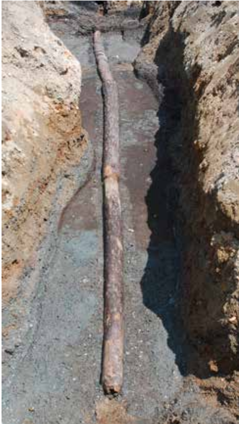
Abb. 11: Innsbruck – Mühlau. Mittelabschnitt der am Oberkoflerweg freigelegten östlichen Deichelleitung.
