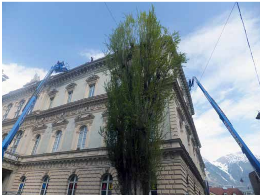
Restaurierung der Dachbalustrade und Attika im Frühjahr 2016.
