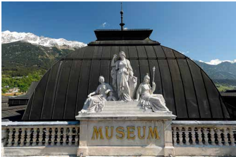
Die Tyrolia strahlt wieder nach den Sanierungsmaßnahmen.
