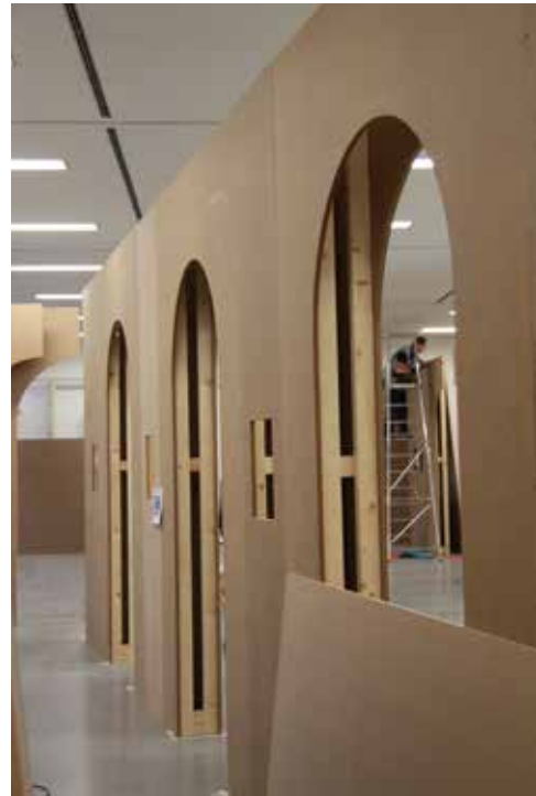
Die ersten Wände für die Sonderausstellung sind angefertigt.
