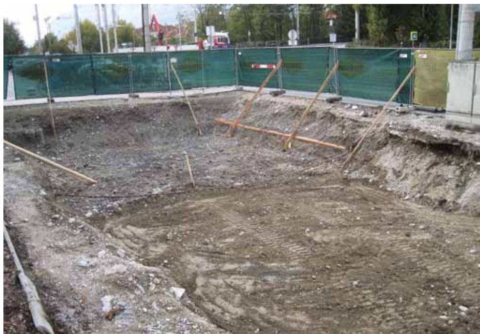
Abb. 21: Innsbruck – Wilten, Areal Innsbrucker Verkehrsbetriebe. Auf Tiefe des geplanten Grundaushubes ausgebaggerte Fläche. Ansicht von Ost-Süd-Ost. (Foto: TLMF)
