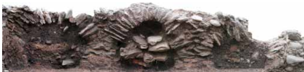
Abb. 15: Innsbruck – Wilten, Graßmayrkreuzung. Gewölbte Heißluftdurchlässe in der Zwischenmauer der beiden nördlichen hypokaustierten Räume, fotografmetrisch entzerrte Ansicht von Norden. (Foto: TLMF)
