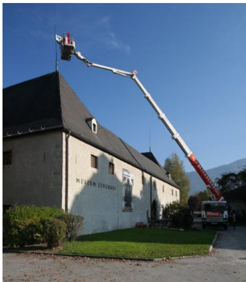
Die vier Blechfahnen auf den Dächern der beiden Längstrakte wurden auf Betreiben des Innsbrucker Verschönerungsvereins restauriert und wieder an ihrer alten Stelle montiert.
