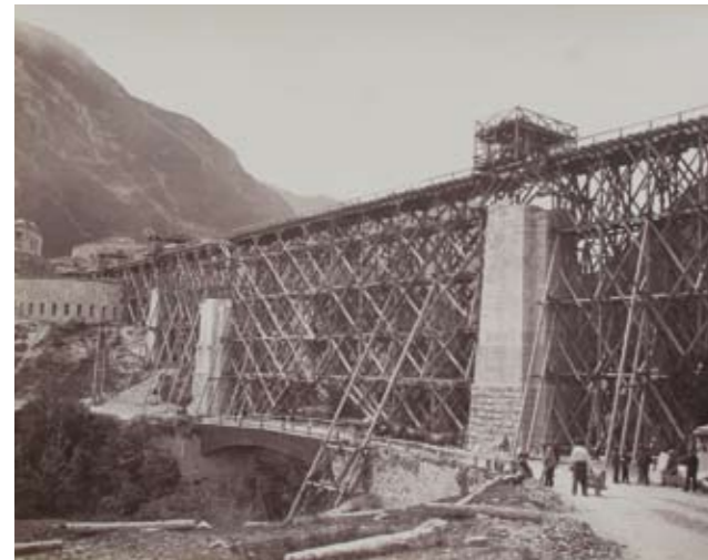
Eisenbahnviadukt der Pustertalbahn bei der Franzensfeste, um 1870. Foto: Emil Lotze, Bozen rechts oben: Plakat der Brennerbahn, hg. von der k.k. priv. Südbahngesellschaft, Chromolithographie, unbeschriftet, gegen 1900, Foto: Pizzinini/TLM
