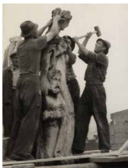
Effektiv und endgültig wurde die drohende Absturzgefahr des figuralen Balustradenschmucks durch Mitarbeiter einer Baufirma 1955 gelöst. Foto: TLMF
