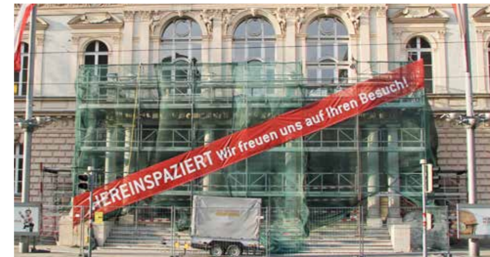
Während der Restaurierung der Balustrade. Foto: TLM
