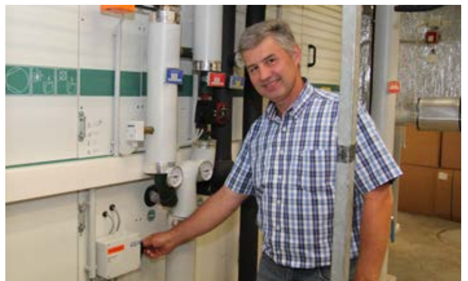
Hubert Haider betätigt die Regelung in der Klimazentrale
