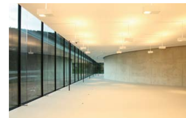
Der Rundgang durch das Museum führt zuerst um die große Rotunde herum, die für das Bergisel-Panorama geschaffen wurde. Dieser zylindrische Bauteil hat einen Durchmesser von 32 Metern und eine Höhe von bis zu 17,5 Metern an seiner in Richtung Sillschlucht weisenden Außenseite, Foto: Stoll/Wagner
